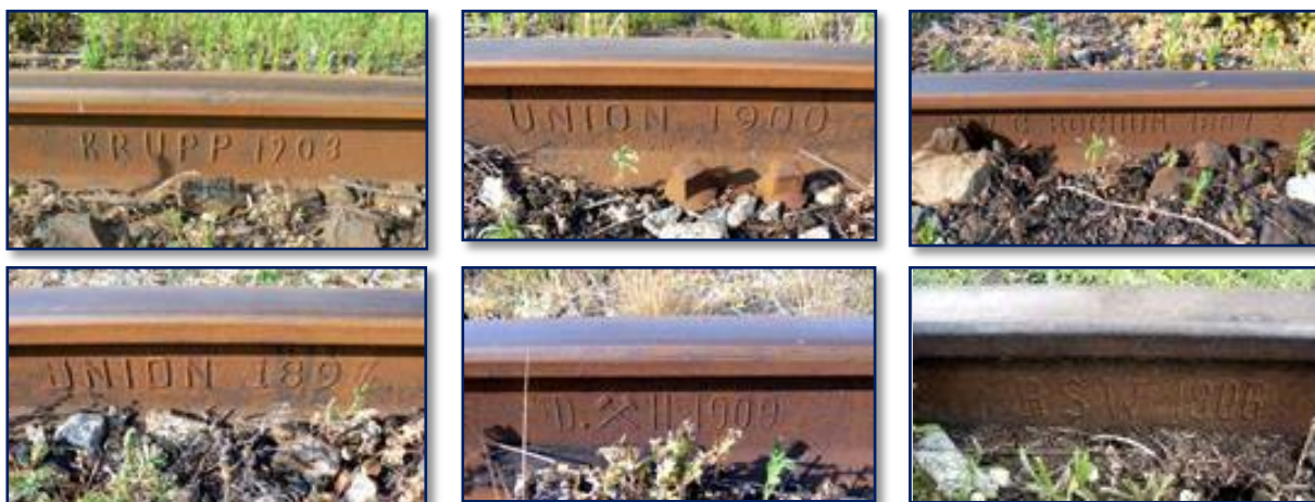
Przykłady oznaczeń hut na szynach średzkiej kolejki. Szyny wymieniono w trakcie zmiany rozstawu z 1000 na 750mm w latach 1952-54.
